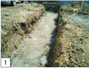
施工場所を掘削して砕石を敷く
