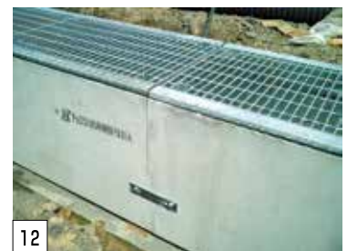
PU3型横断側溝500A×2,000(ノンスリップ)T-25 プレートにて連結
