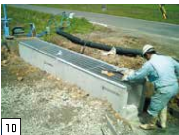
PU3型横断側溝500A×2,000(ノンスリップ)T-25 連結状況
