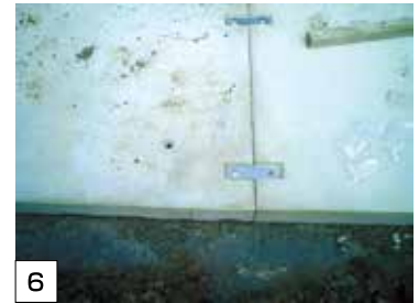
連結部は連結プレートにて連結する
