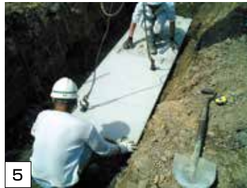
2枚目以降は2.0mのベースプレートを設置する
