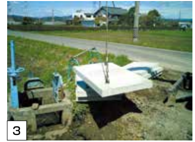
重機にて2点で吊り上げる
