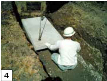
本体が2.0mのため1.5mのベースプレートを設置
