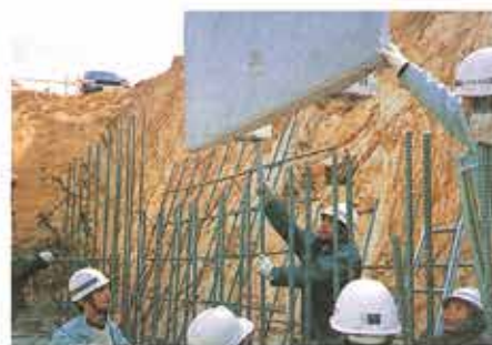
⑥フロントブロック設置
