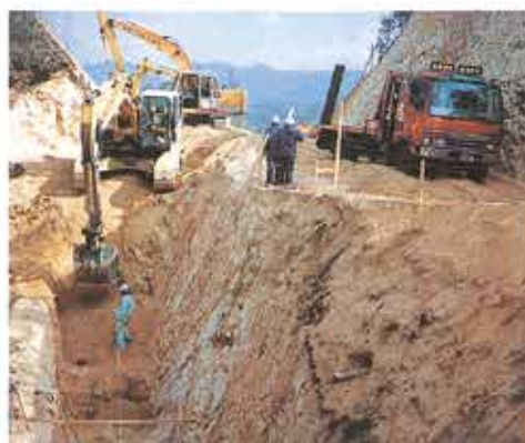
②基礎掘削
