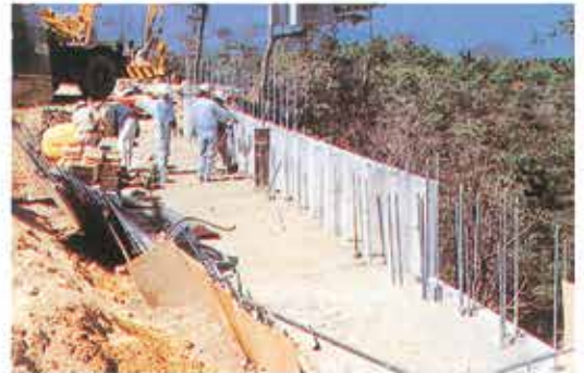
⑫擁壁背面側状況
