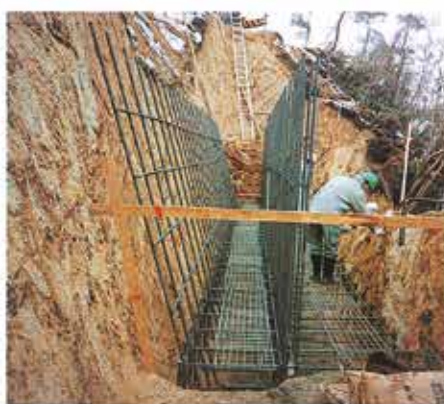
④鉄筋組み立て
