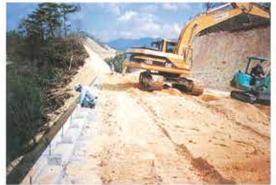
⑬完成間近天端状況
