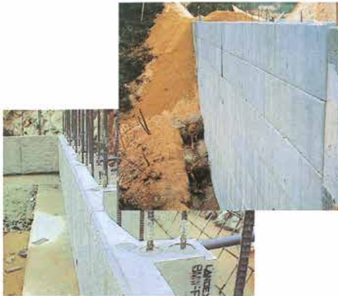
⑪擁壁前面側状況
