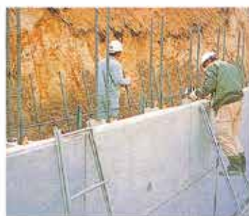
⑩フロントブロック設置
