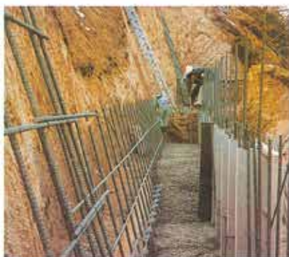
⑨背面側コンクリート打設
