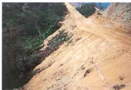
①工事着工前
