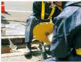
ブレード交換
