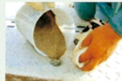
蓋のアンカー筋孔に。
