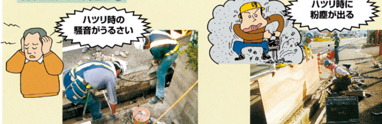
従来工法であるコンクリートブレイカーによるハツリ作業
