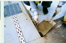
蓋の高さ調整、舗装面などとの隙間に。
