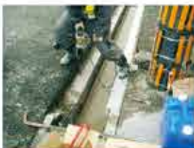
アンカー筋部削孔
