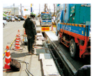
岡山県倉敷市
