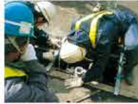
専用治具によるレールのセット
