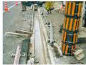
レール取り外し、切断部撤去
